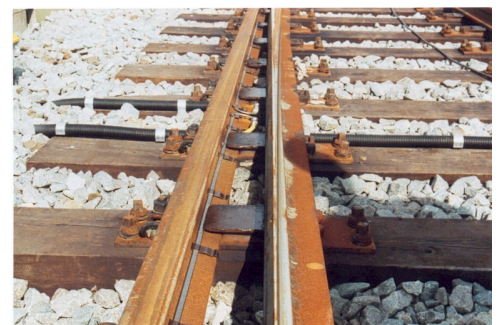
Die Weichenzunge gleitet über die Anschlussköpfe hinweg; Blick unter der Zunge hindurch
