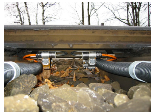
Die Weichenzunge gleitet über die Anschlussköpfe hinweg; Blick unter der Zunge hindurch
