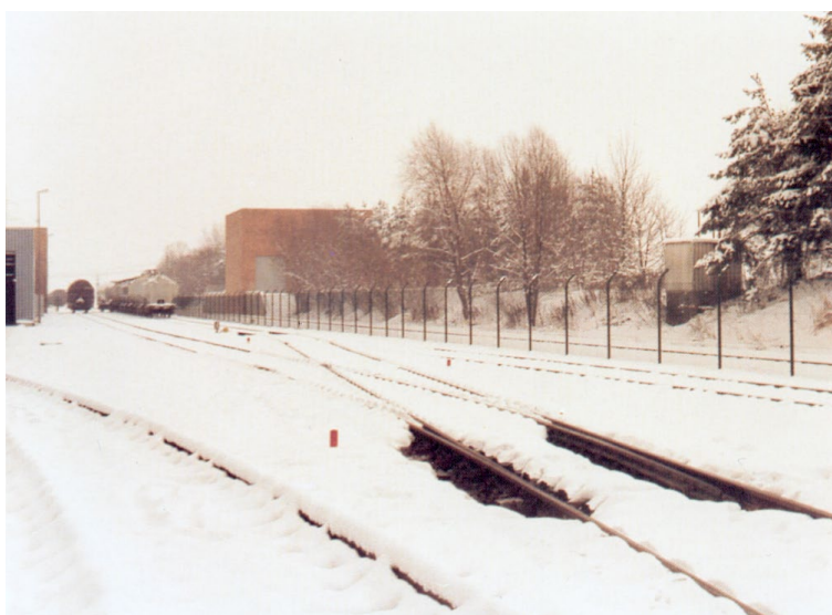
Zungenheizung und Verschchlussfachheizung bei Holzschwellen
