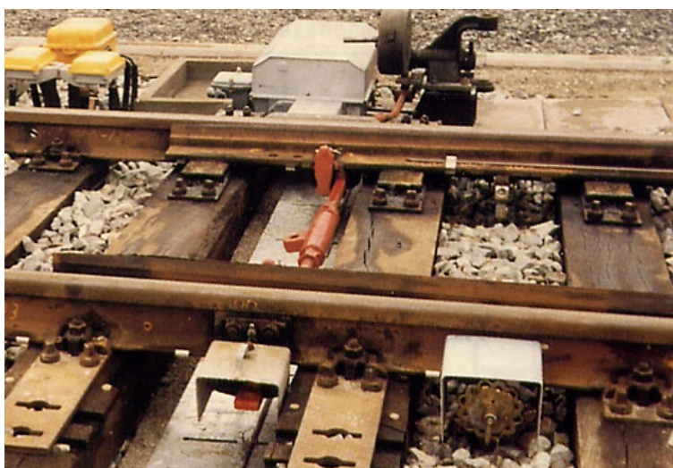
Zungenheizung und Verschchlussfachheizung bei Holzschwellen
