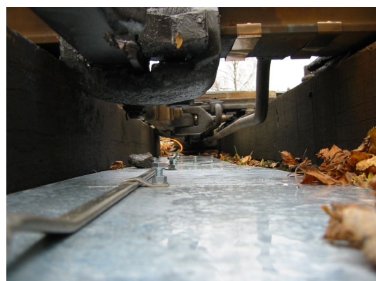
Verschlussfachheizung eingelegt unter Verschlussgestänge auf Schotterbett
