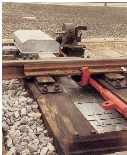
Verschlussfachheizung eingelegt unter Verschlussgestänge auf Schotterbett
