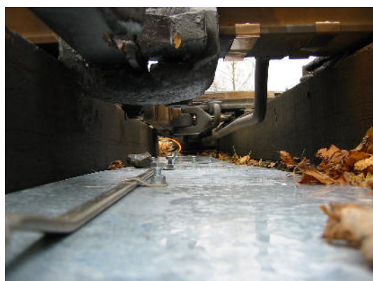
Verschchlussfachheizung eingelegt unter Verschlussgestänge auf Schotterbett
