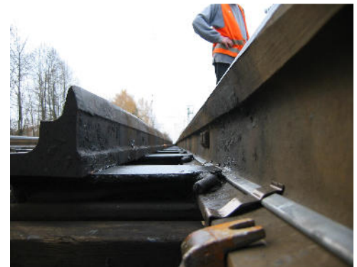
Lage des Heizstabes im Freiraum zwischen Gleitstühlen und Schienensteg
