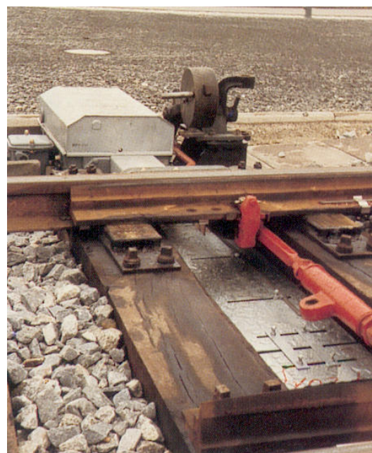
Verschchlussfachheizung eingelegt unter Verschlussgestänge auf Schotterbett
