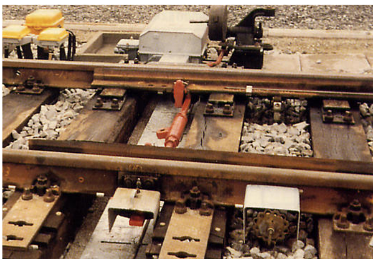
Zungenheizung und Verschchlussfachheizung bei Holzschwellen
