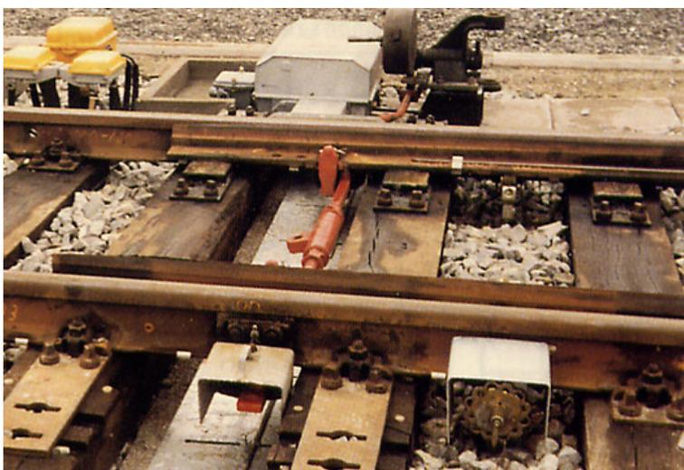
Zungenheizung und Verschlußfachheizung bei Holzschwellen
