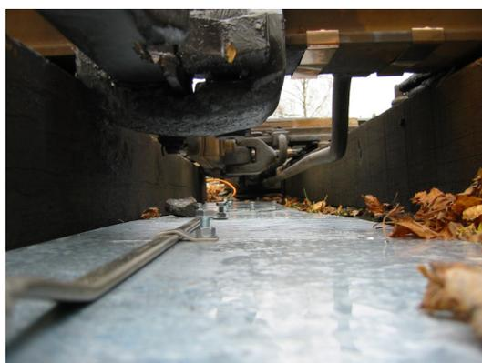
Verschlußfachheizung eingelegt unter Verschlußgestänge auf Schotterbett
